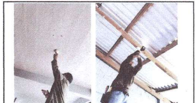
Foto 10: Sustitución de focos ahorradores y plafoneras
