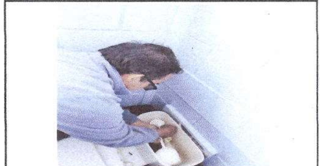
Foto 8: Sustitución de accesorios inodoro (contra llave, tuboi de abasto y tanque)
