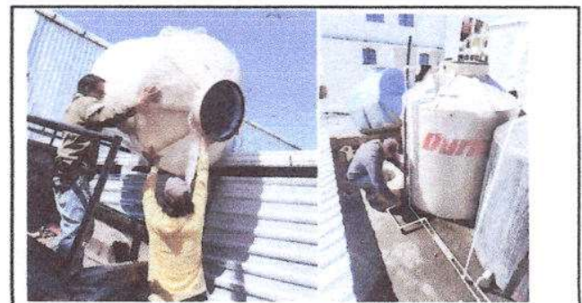
Foto 12: Sustitución de depósito de agua de 1100 litros
