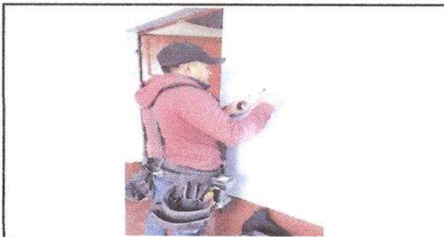
Foto 11: Sustitución de tomacorrientes
