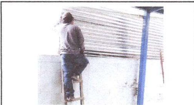
Foto 9: Muros perimetrales, reparación de tubos hg
